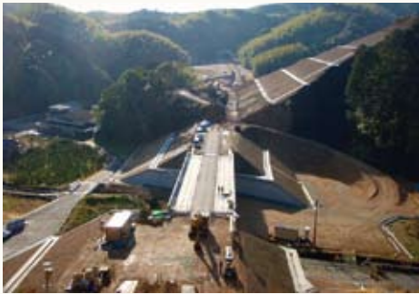
小松島市田野町で進む四国横断自動車道建設工事
