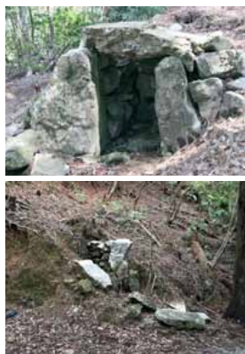
上) 原形をとどめている石室 下) 崩壊した石室
