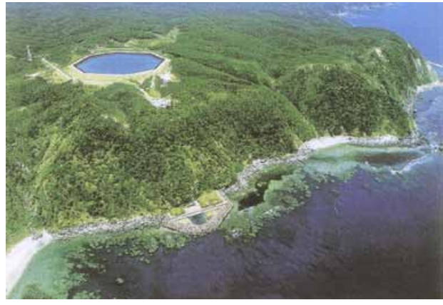
上空から見た沖縄やんばる海水揚水発電所。
