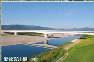
新那賀川橋(仮称)
