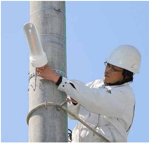
取り付けしたLED防犯灯の全長は約75cmと従来の蛍光灯の半分の大きさです。
