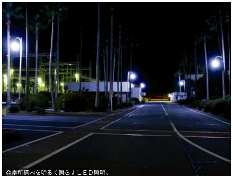
発電所構内を明るく照らすLED照明。
