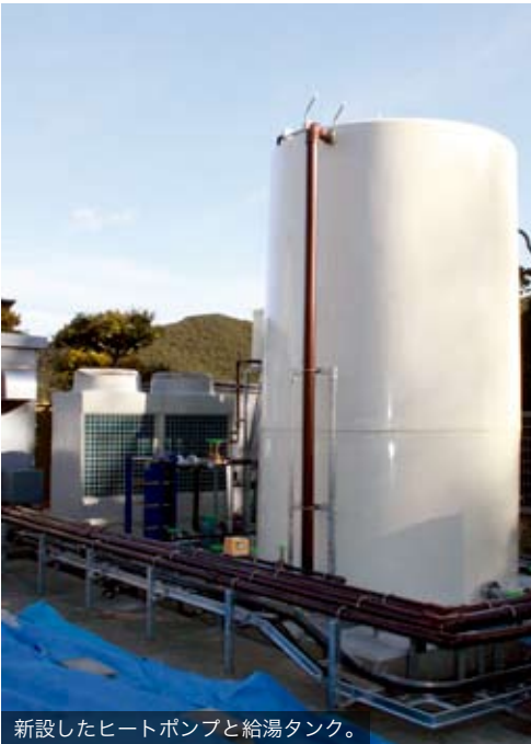
新設したヒートポンプと給湯タンク。
