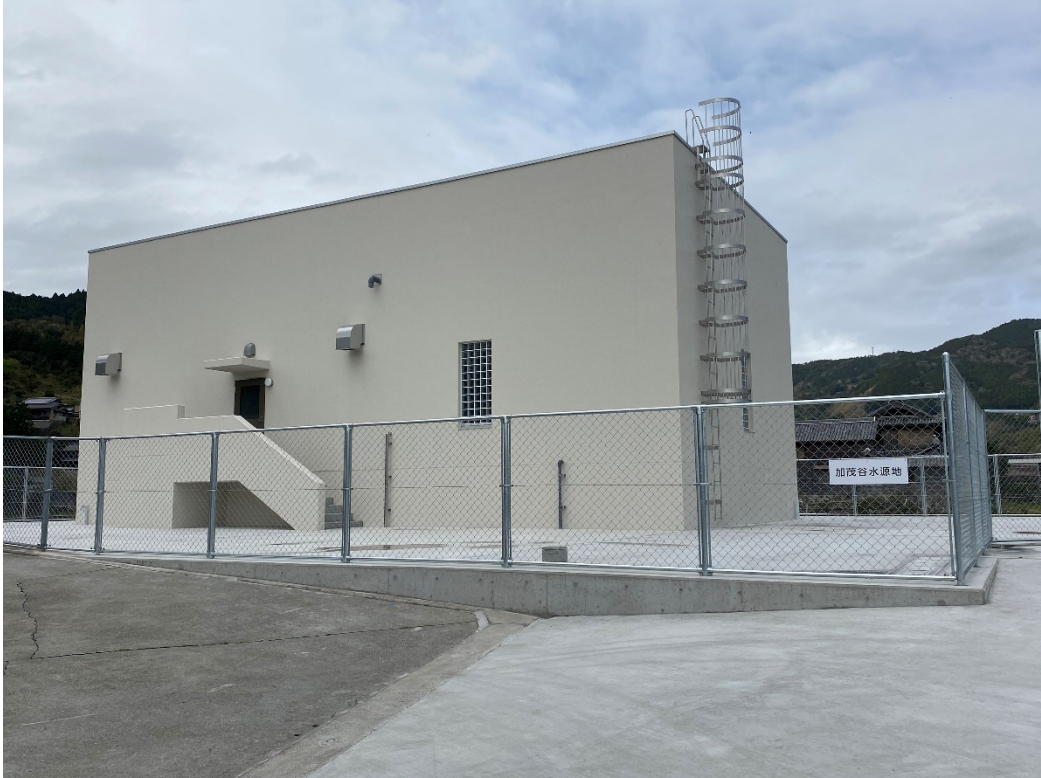
阿南市上水道加茂谷水源地
