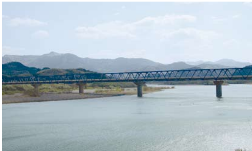
持井橋(上大野町一上大野町)
