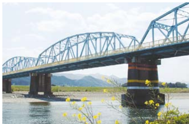
那賀川橋(上中町一羽ノ浦町)
